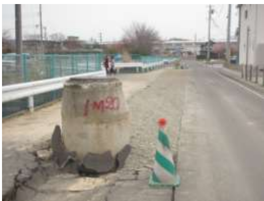
図5 白石市東町3丁目 人孔の抜け上がり
