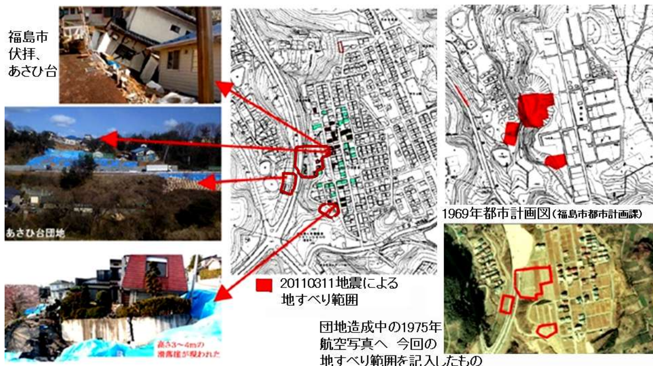
図2-1 福島市伏拝、あさひ台の人工地盤の崩壊地すべり
