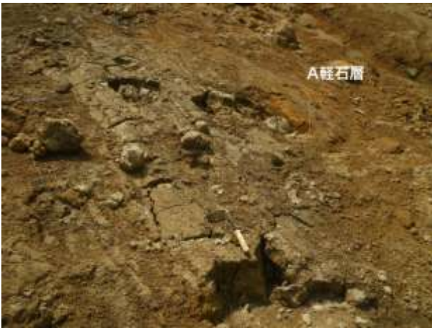
図3-4 すべり面に露出するA軽石層直下のローム質粘土層と薄く残存しているA軽石層
