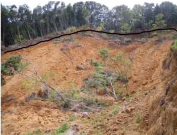
図3-5 A・B軽石層上位の厚い砂質ローム質粘土層とその上位の黒色土壌と盛り土
