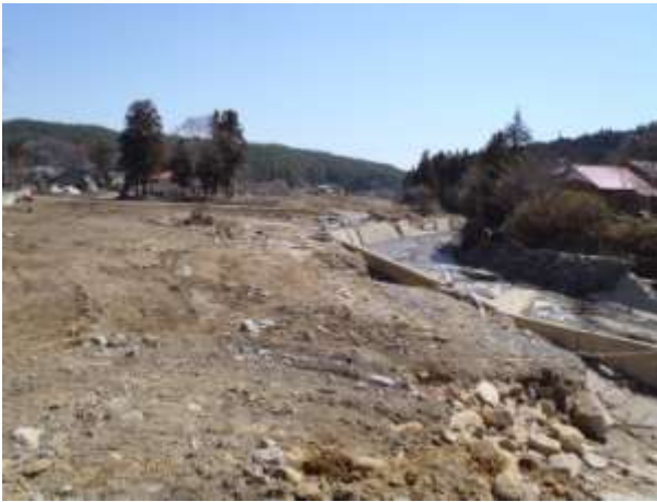
図4-3 滝集落の氾濫現場 (2011/04/11撮影)
