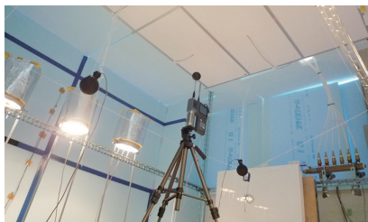
地中熱をカスケード利用した快適な天井放射暖冷房システム実験
