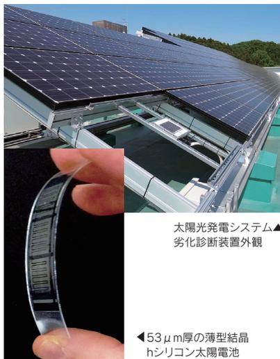
太陽光発電システム▲劣化診断装置外観
