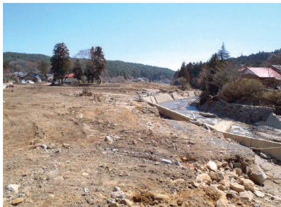
図4-3 滝集落の氾濫現場 (2011/04/11撮影)
