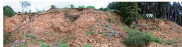
図3-5 A・B軽石層上位の厚い砂質ローム質粘土層とその上位の黒色土壌と盛り土
